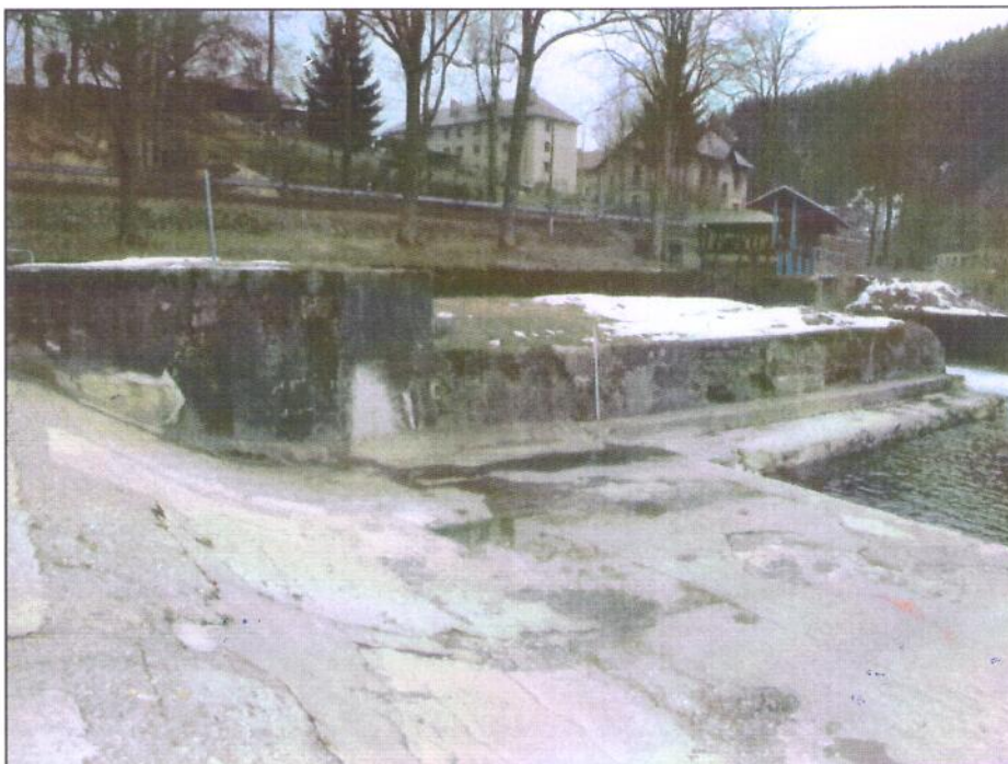
Obrázek 3 - levý břeh, zeď podjezí
